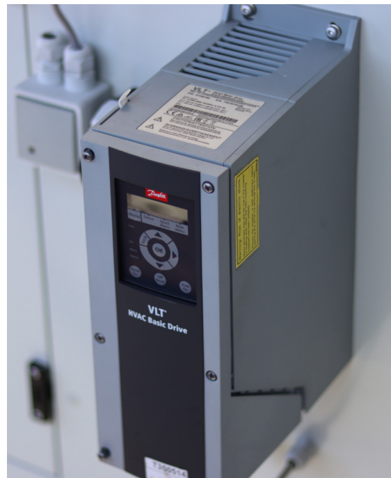
Afbeelding: geschikt maken frequentieregeling
