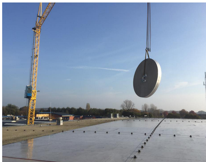
Afbeelding: vervangen warmtewiel rotor
