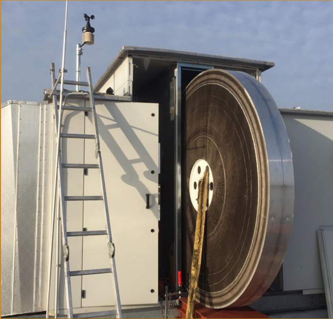
Afbeelding: vervangen warmtewiel rotor
