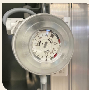
Figuur 5. Drukverschilopnemer over het buitenluchtaanzuigfilter
